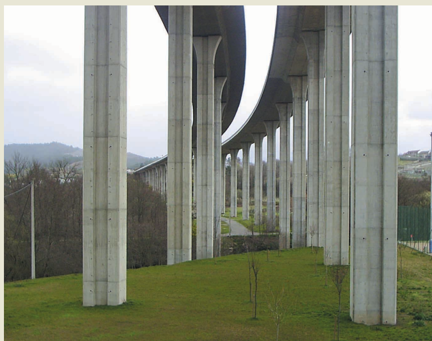
Viaducto de Ribadavia (Ourense), A-52.
