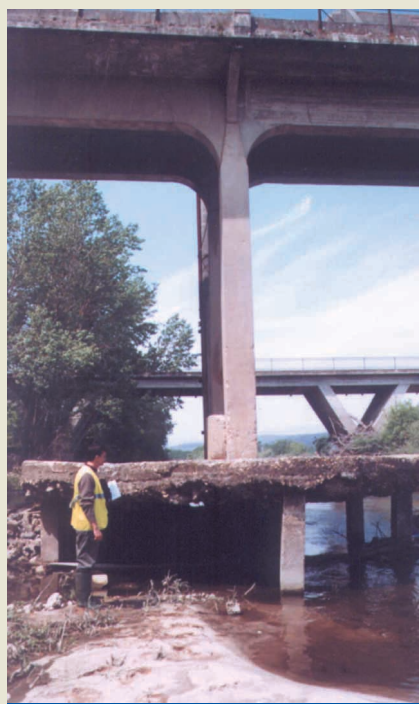
Figura 6. Socavación profunda.
