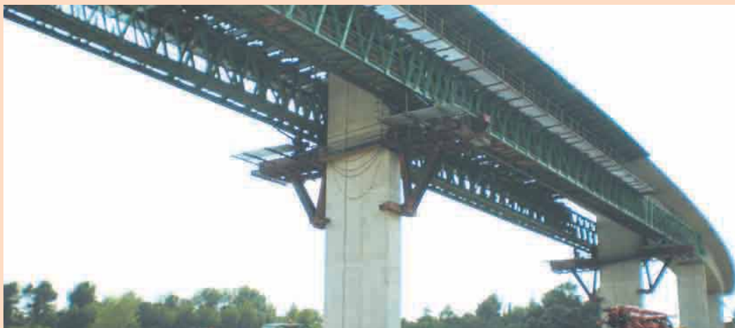
Colección de imágenes donde se aprecia la ejecución del Viaducto del Llobregat mediante cimbra autoportante.
