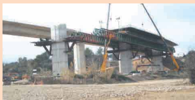
Colección de imágenes donde se aprecia la ejecución del Viaducto del Llobregat mediante cimbra autoportante.
