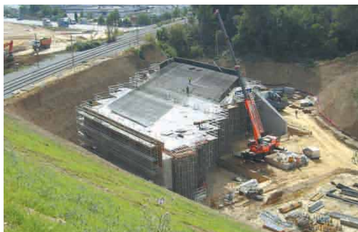
Construcción del cajón hincado.
