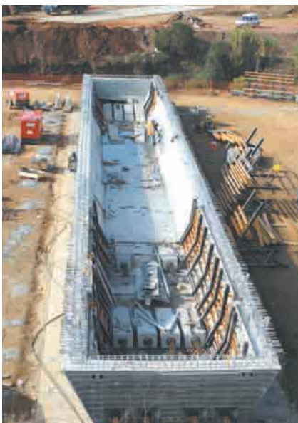
Viga prefabricada en obra.
