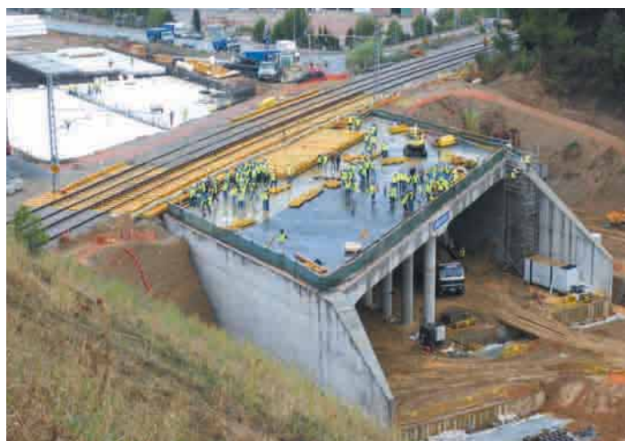
Empuje del cajón hincado.
