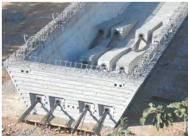
Detalle de los anclajes de las vigas.
