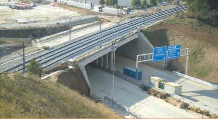
Cajón hincado finalizado.
