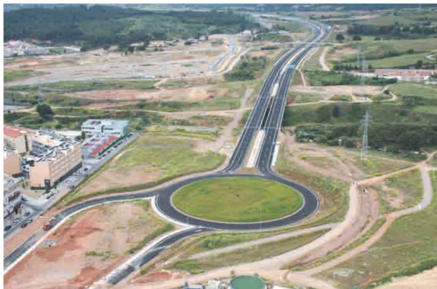
Finalización del tramo. Conexión Terrassa Norte.
