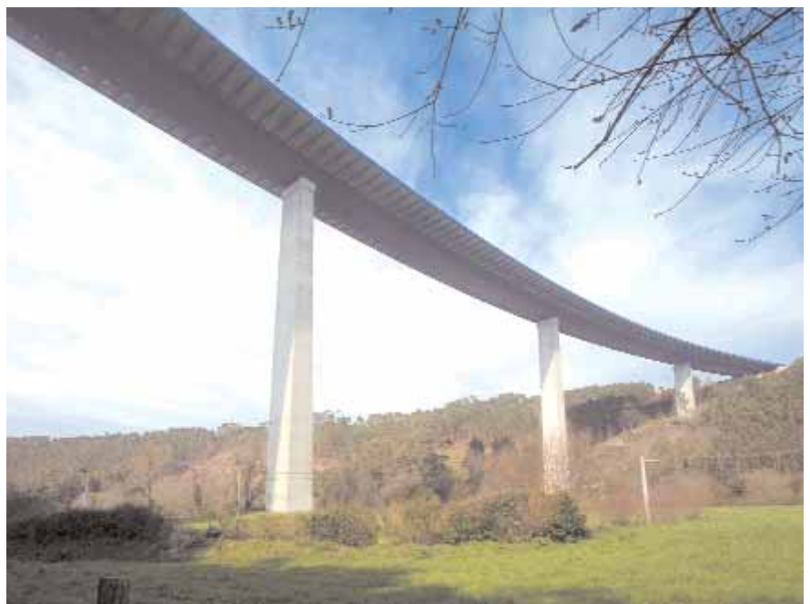
Viaducto de Canero, de 470 m de longitud total.
