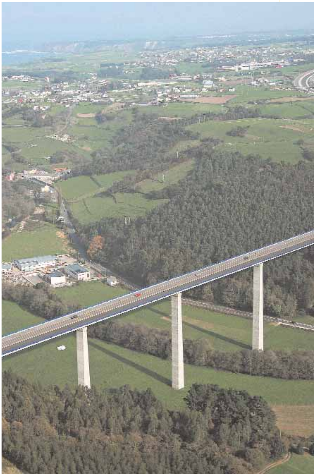
Vista panorámica del viaducto de San Timoteo, de 540 m de longitud, dividida en 7 vanos.
