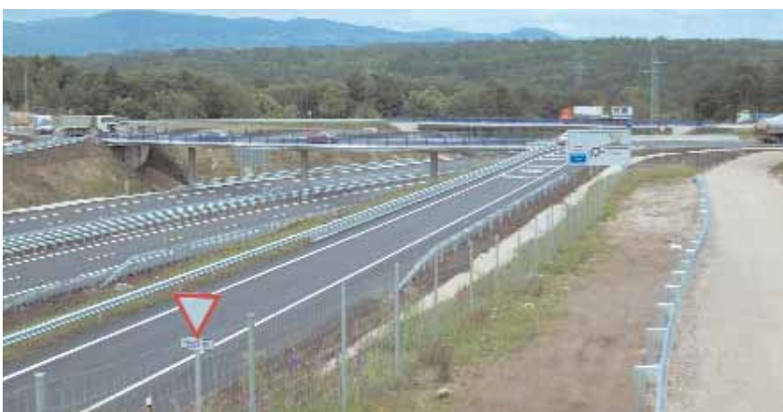
Arriba: Vista aérea del comienzo del tramo Vilalba-Regovide, diseñado para una velocidad de 120 km/h. Abajo: faldones de protección para motoristas.
