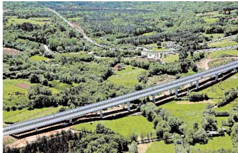
En la foto, el viaducto sobre el río Trimaz, desde otra perspectiva.
