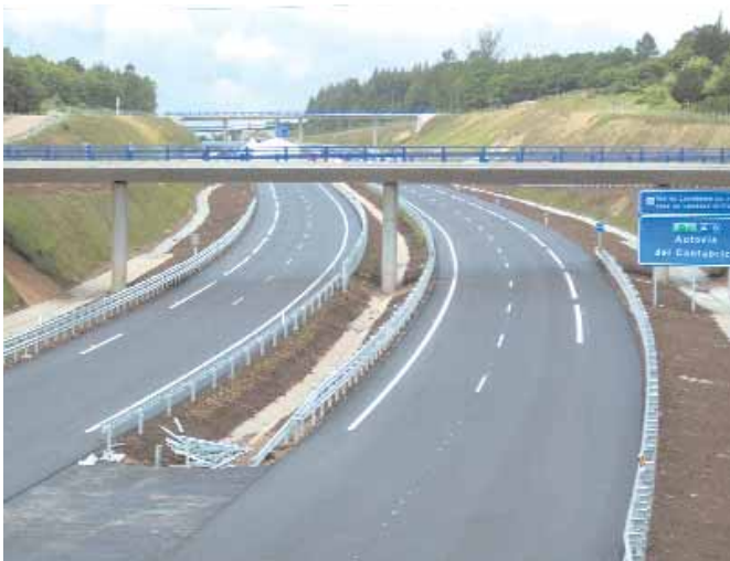
Vista del tramo inaugurado en el p.k. 5+200, en la que se aprecian 2 de los 7 pasos superiores instalados en su recorrido.
