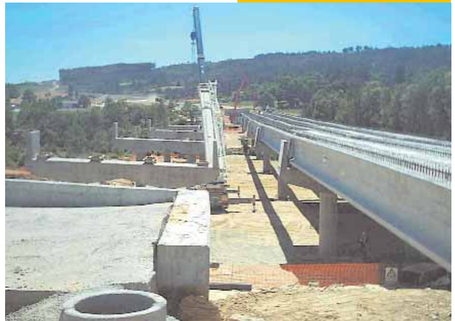
Vista general de la construcción del viaducto.
