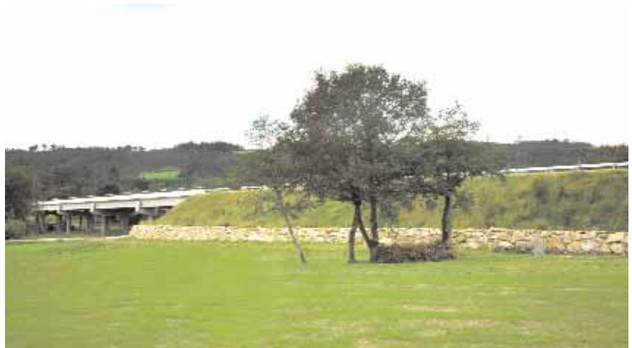
Vista del muro de escollera y estribo 1 del viaducto sobre el río Labrada.
