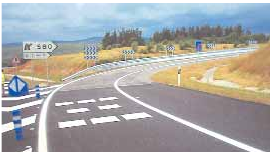
Barreras con protección para motoristas.
