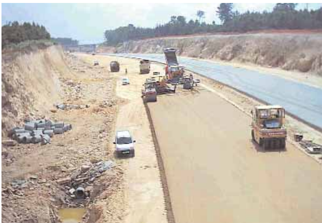
A lo largo del tramo se han extendido 43 100 m³ de suelo cemento.
