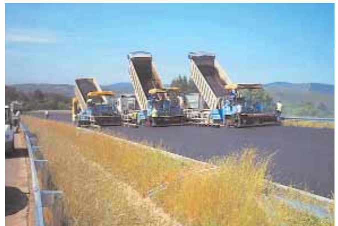
Extensión de la mezcla bituminosa PA-12, en el p.k. 2+200 del tramo.
