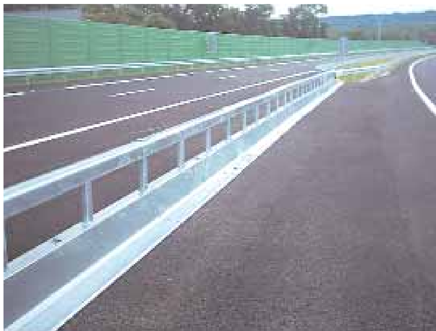
Paso de mediana y pantallas antiruido.
