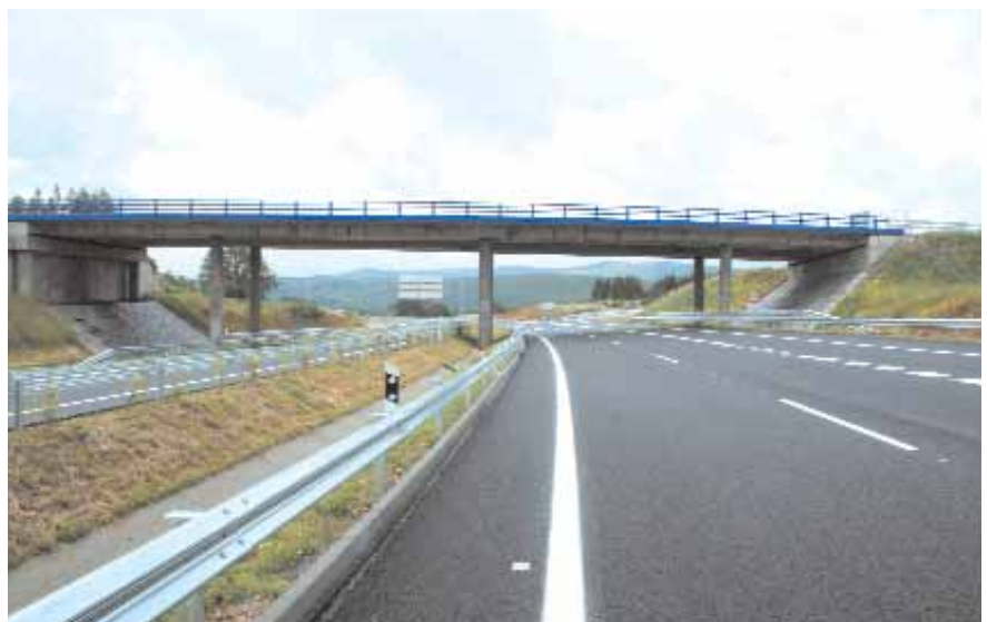
Además del enlace, en este tramo se han construido 13 estructuras. En la foto, uno de los 5 pasos superiores dispuestos a la largo del itinerario.
