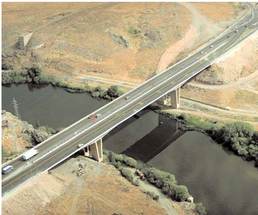
Un total de 11 puentes se han construido en esta ronda de circunvalación.
