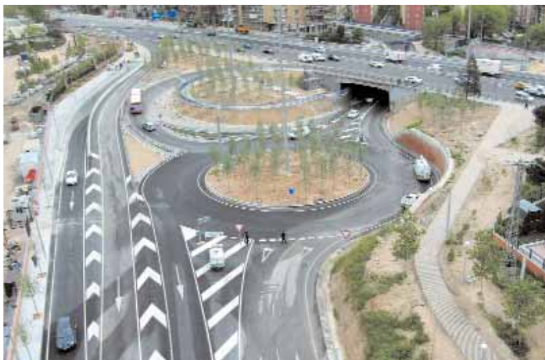
Soterramiento de la Avda. de Portugal entre el paseo de Extremadura y la M-30.
