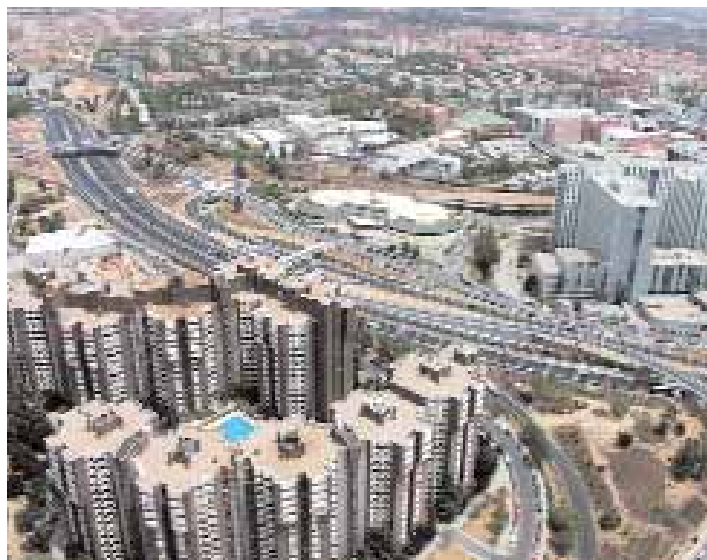
Se ha creado un nuevo acceso de la Avda. de la Ilustración con la carretera de Colmenar, M-607.
