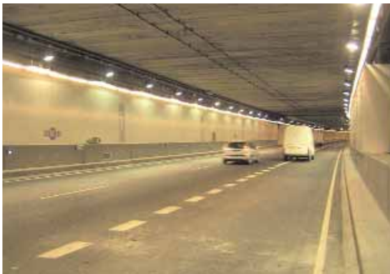
Túnel Norte Conde de Casal-Paseo de la Chopera.
