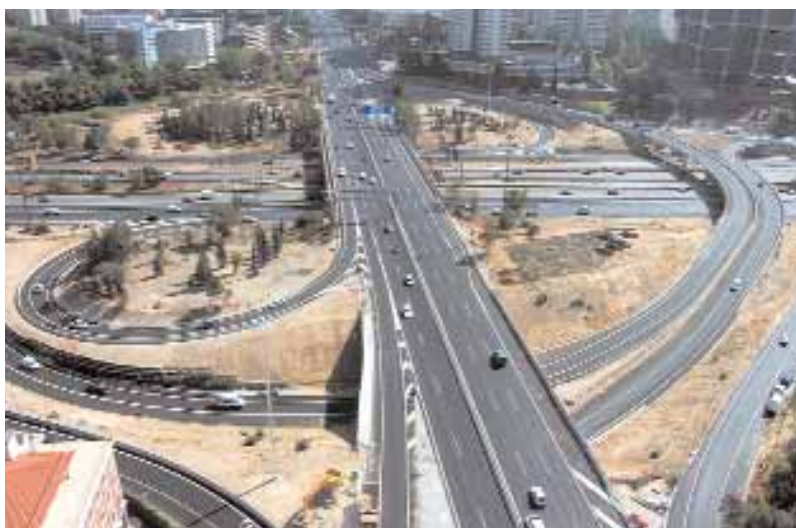
Remodelación del enlace de la M-30 con la avenida de América/A-2.
