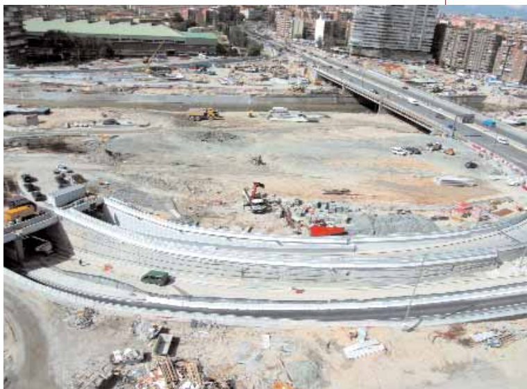
El By-pass Sur de la M-30 es un tramo subterráneo constituido por dos túneles gemelos unidireccionales, de 4,2 km de longitud aproximada,
