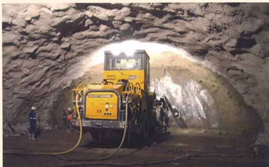
Jumbo perforador de tres brazos trabajando en modo semiautomático.
