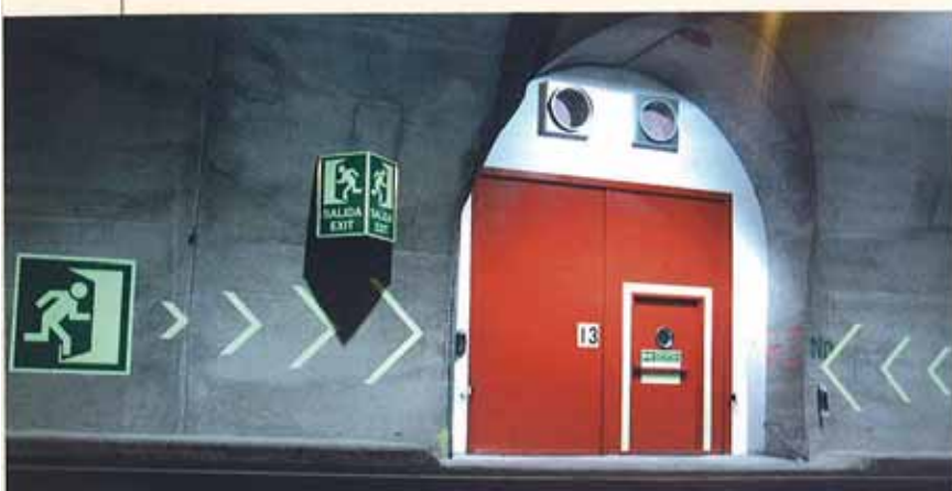
Salida de emergencia: acceso a galería de evacuación desde el túnel 3.
