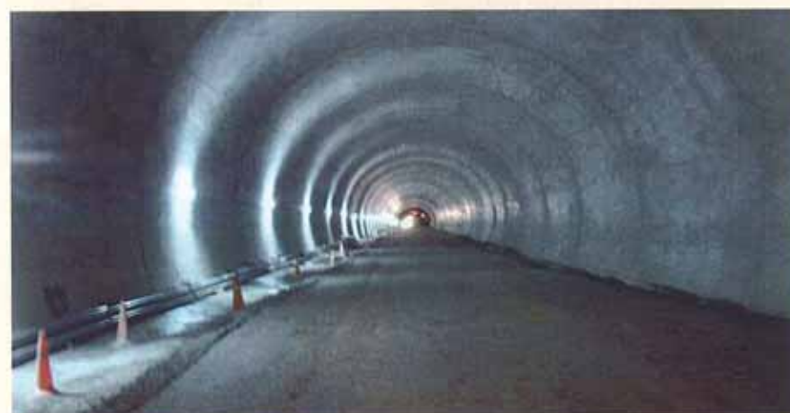
Sección revestida completada.
