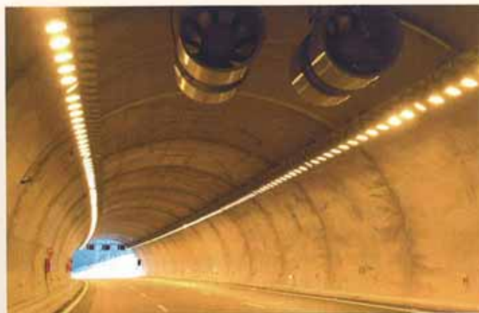
Interior túnel 3 antes de su puesta en servicio.
