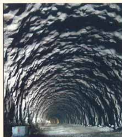
Sección completa excavada.
