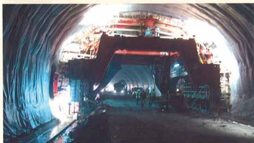
Carro de encofrado trabajando en zona impermeabilizada.
