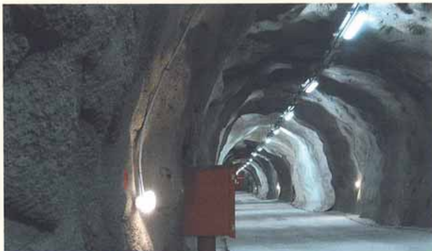
Interior de galería de conexión para evacuación.
