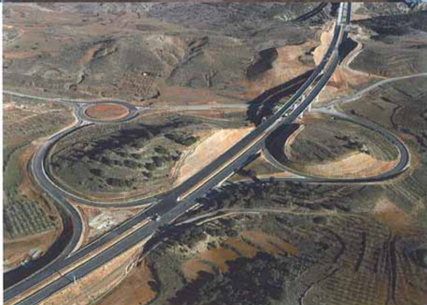
Foto superior: vista del tramo inaugurado. Foto inferior: enlace y viaducto de Mora de Rubielos, de cinco vanos y 235 m de longitud.
