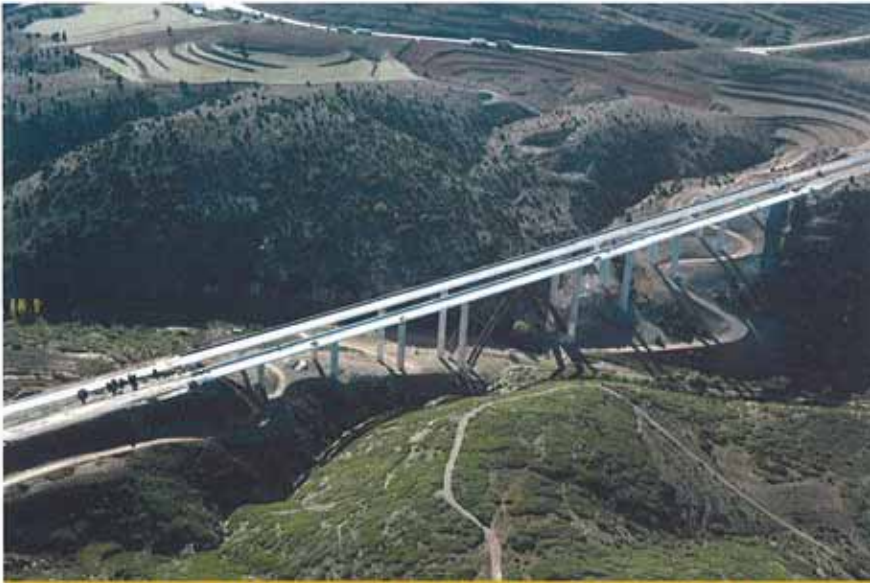
Viaducto sobre el río Albentosa, de 11 vanos y una longitud total de 514 m.
