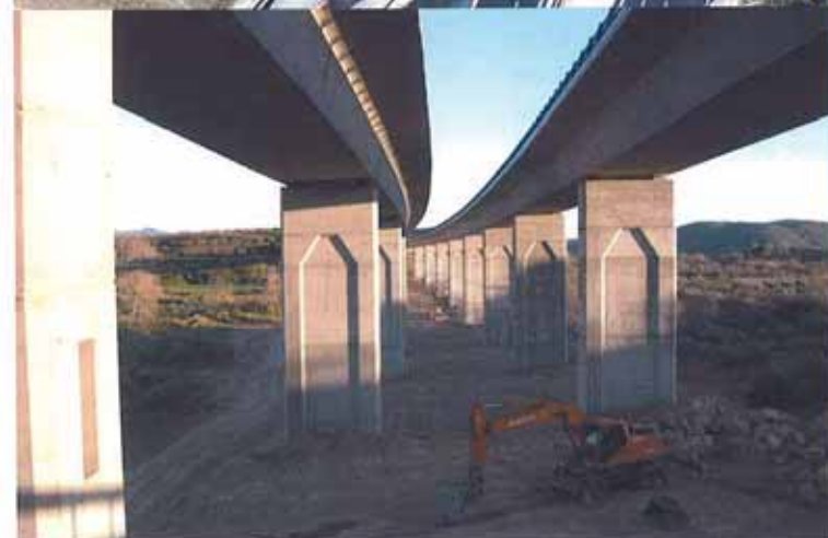
En la foto superior, vista general del tramo. En la foto inferior, detalle de viaducto en construcción.
