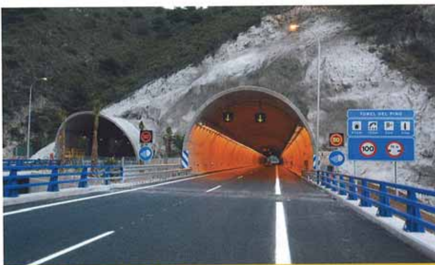
Túnel del Pino de 400 m de longitud.
