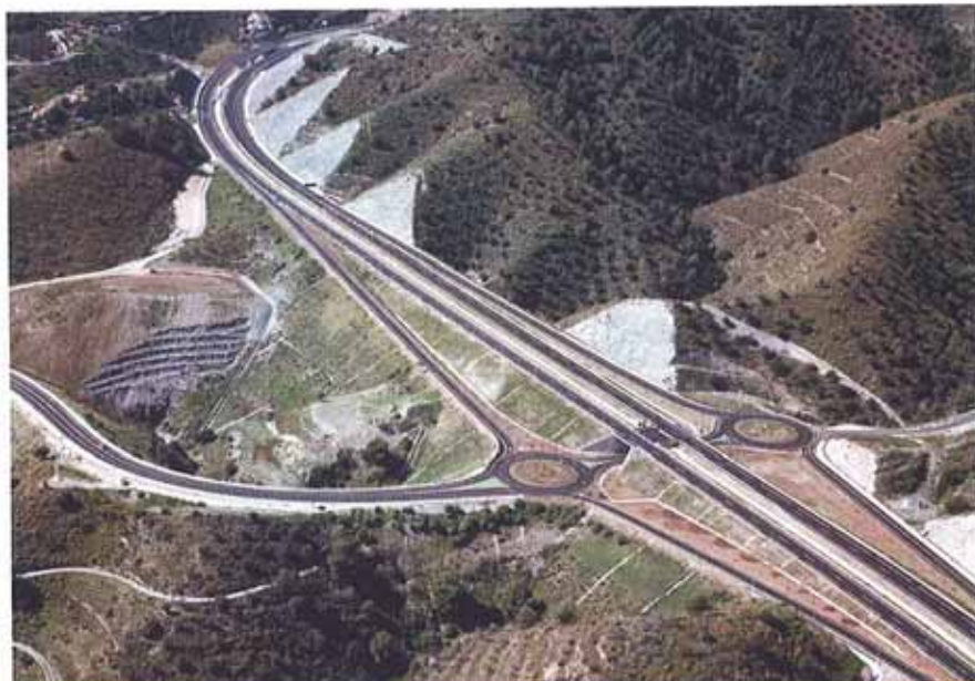
La obra dispone de un único enlace, La Herradura, de tipo diamante deprimido.
