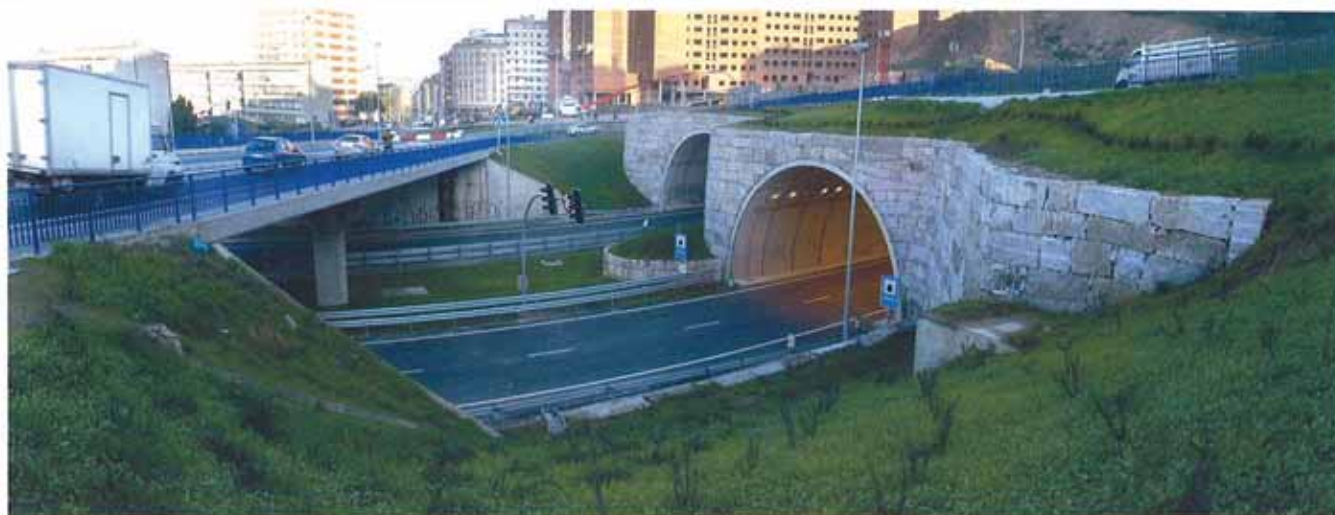
Túneles bajo el barrio de Eirís, de 400 m de longitud total.
