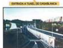
ENTRADA A TÚNEL DE CASABLANCA
