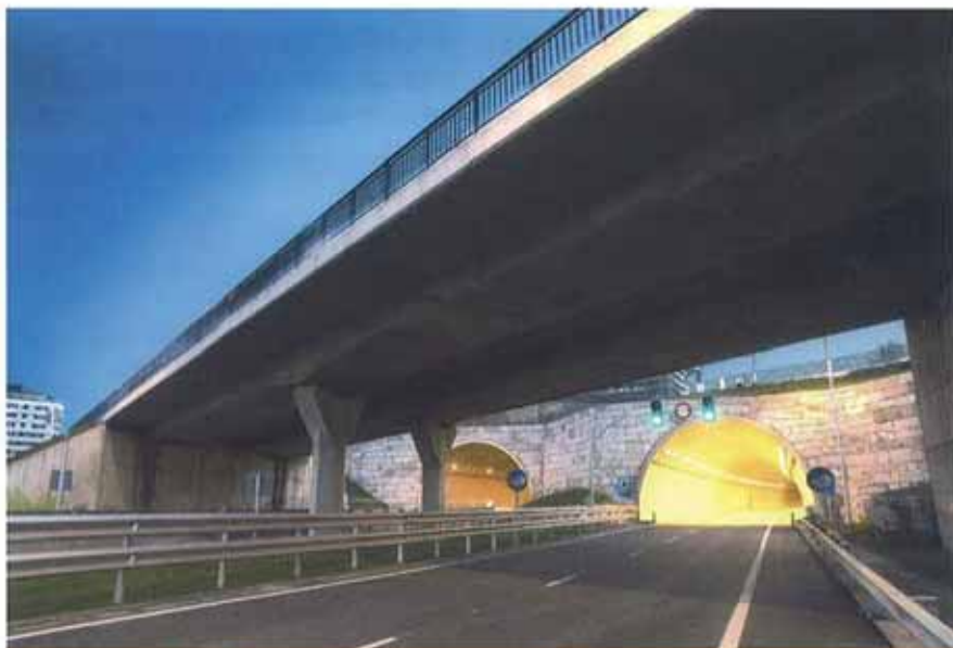
Paso superior. Vial Olímpico y entrada al túnel de Eirís.
