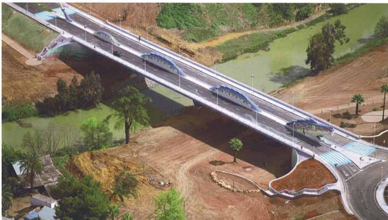
El puente tiene una longitud de 123 m distribuidos en cuatro vanos de 18,50 m los laterales, y 43 m los centrales.
