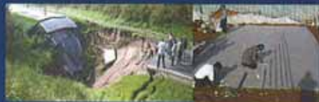
Geocompuestos de refuerzo ROCK PEC sobre suelos muy blandos.
