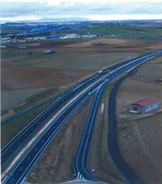
El tramo discurre por el corredor de la N-420 al ser una duplicación de esta carretera.
