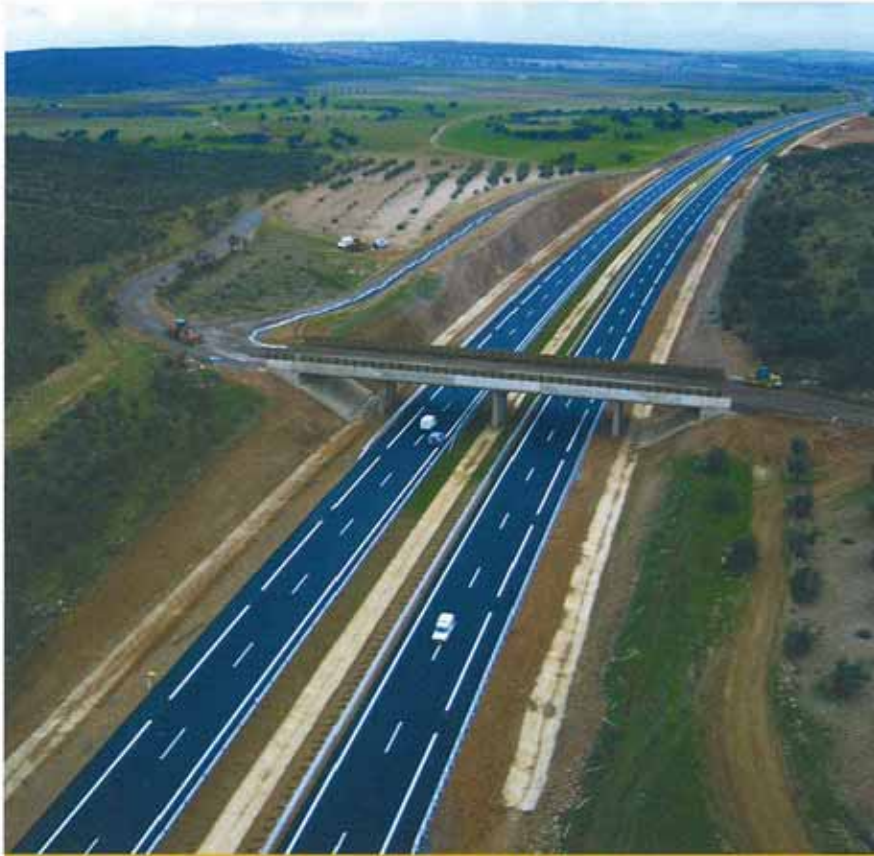
Se han ejecutado 2 enlaces y un total de 16 estructuras (dos para los enlaces).
