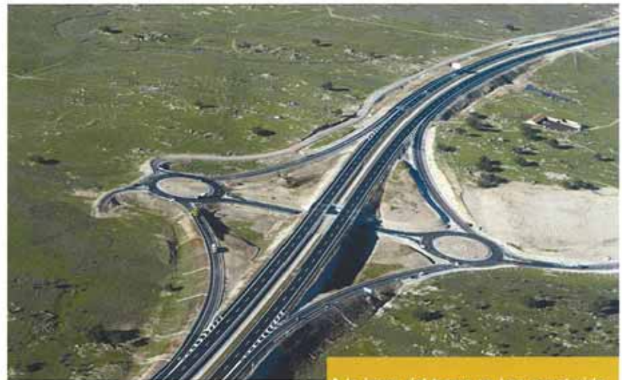
A lo largo del tramo se han construido 3 enlaces, 13 pasos inferiores, 7 superiores y 70 obras de drenaje.
