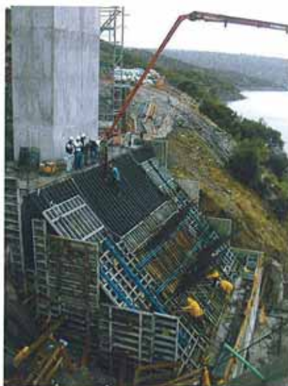
Proceso constructivo de los arcos de Alconétar sobre el río Tajo. Abajo: Hormigonado de la zapata de arranque de aproximadamente 1500 m 3 .
