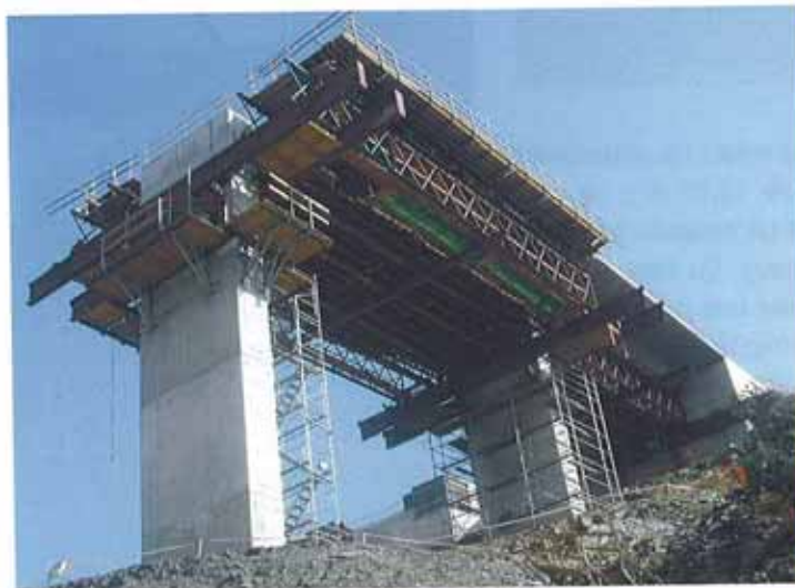
Autocimbra trabajando en los viaductos de acompañamiento.
