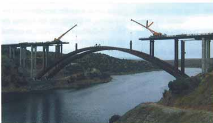
Fases finales de la construcción.
