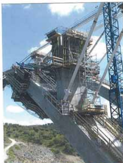
Detalle de trepa de pila sobre el arco.
