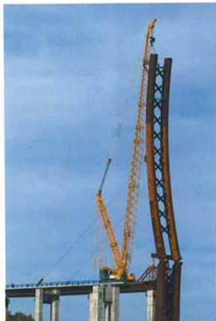
Grúa procediendo al izado del segundo cuarto de arco.
