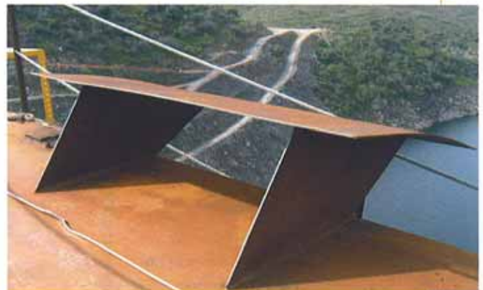
Deflectores colocados en las aristas de los cajones.
