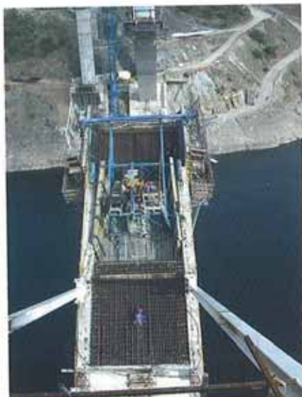
Fases de trabajo del carro de encofrado.
