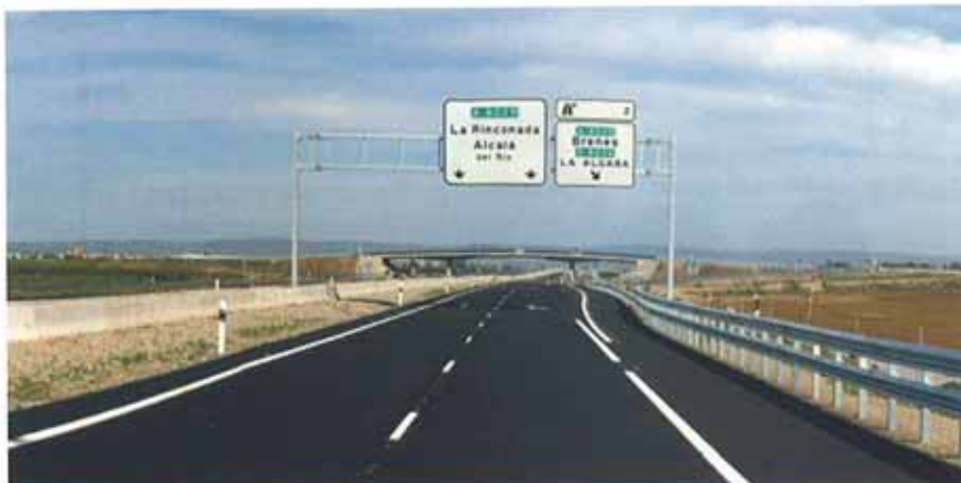
El tramo interurbano tiene una longitud de 8,36 km.
