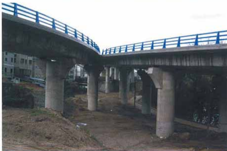
El viaducto de Ribeiño está formado por dos viaductos independientes de 12 vanos, que alcanzan una longitud total de 417 m entre ejes de apoyo en estribos.
