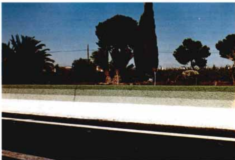
Estética de la barrera de seguridad de hormigón (Acceso Norte. Alicante)
