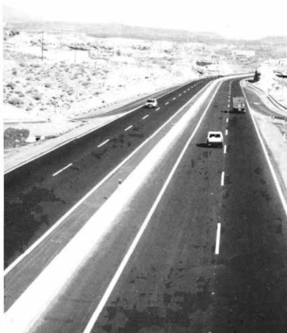
Barrera de seguridad de hormigón en la Autopista TF-1 (Tenerife)
