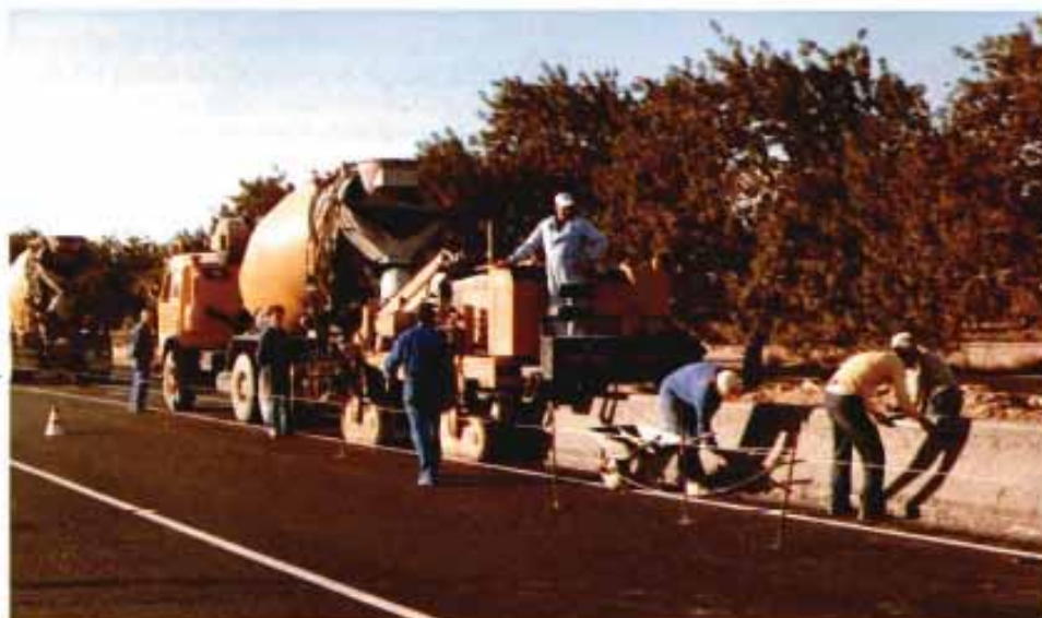
Construcción de la barrera con una máquina de encofrados deslizantes. Acceso Norte, Alicante.
