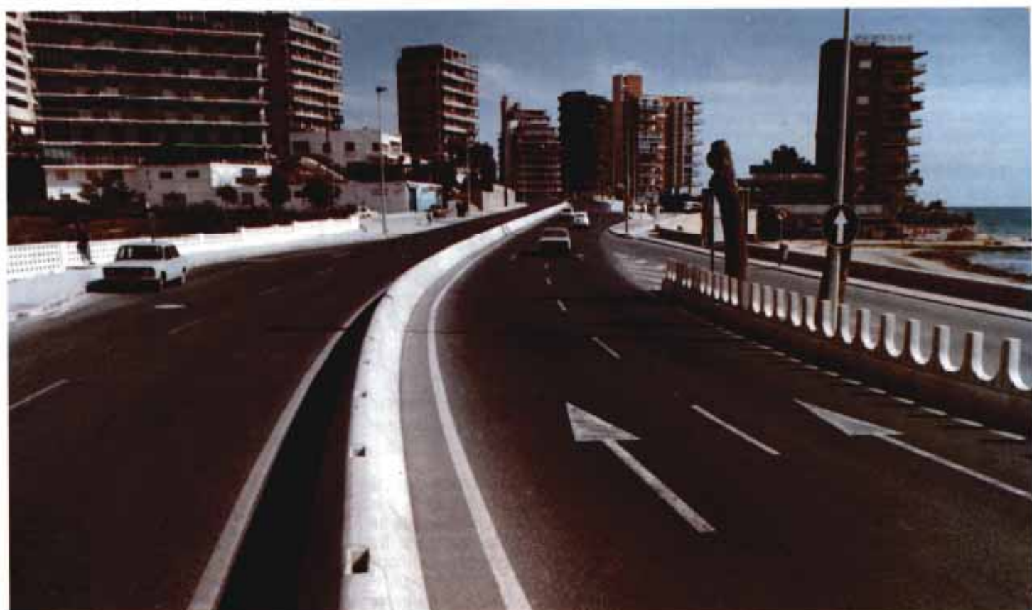
Barrera de seguridad de hormigón prefabricada. La Albufereta (Alicante).
