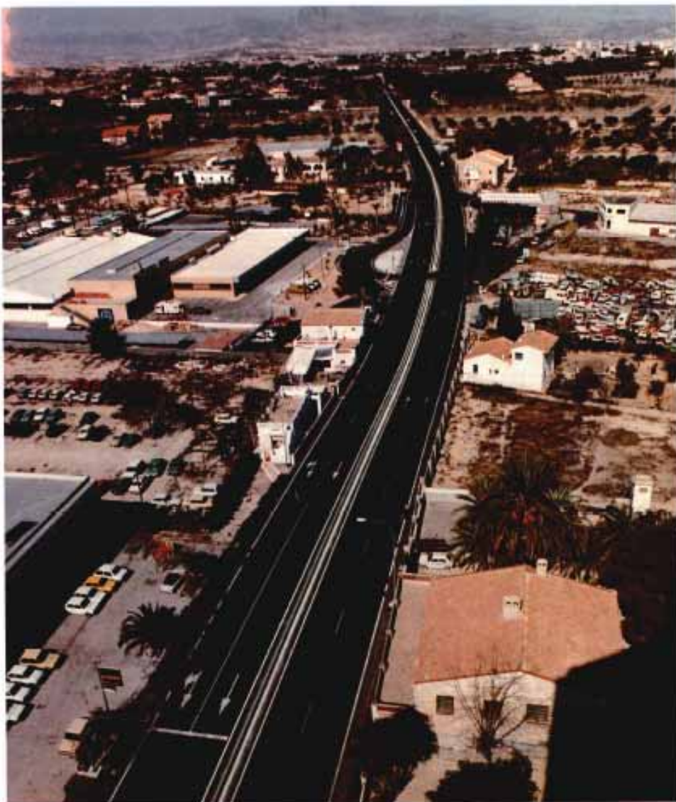
Barrera de seguridad de hormigón en el Acceso Norte a Alicante
