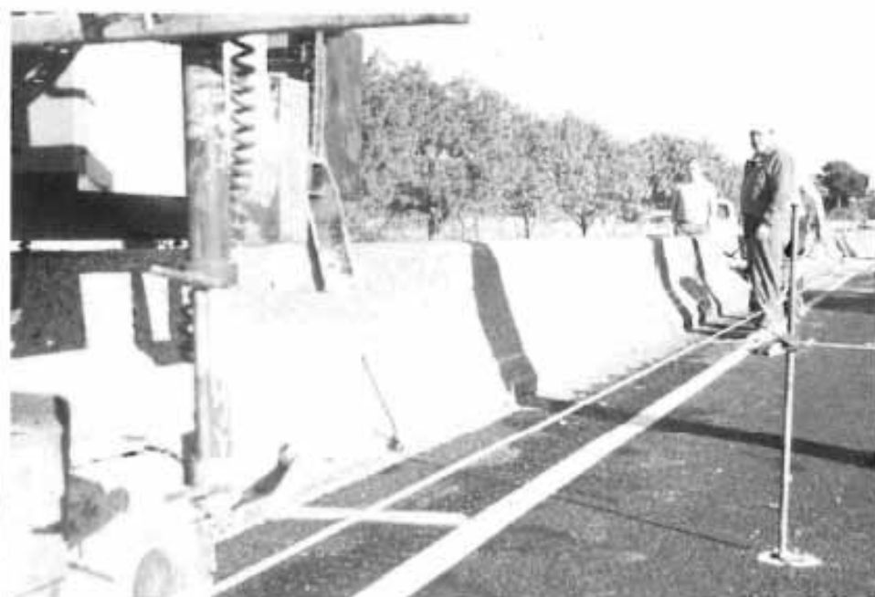
Construcción de una barrera de seguridad en Alicante (Acceso Norte)
