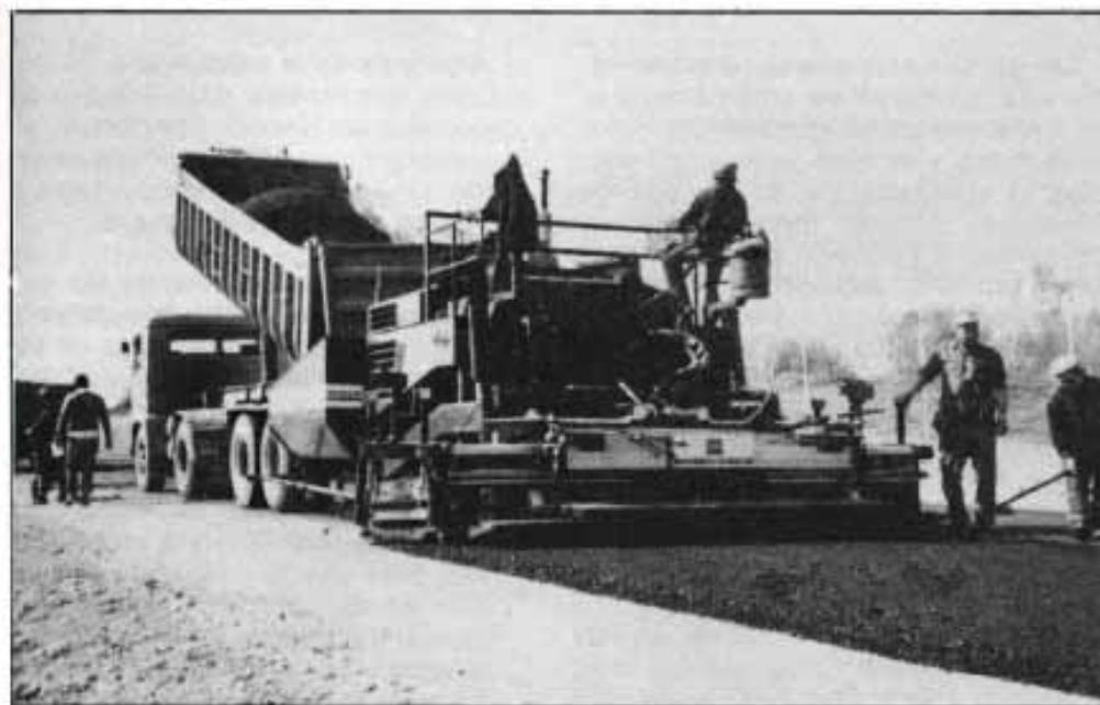
Extendido, sobre una capa granular, de 8 cm. de mezcla bituminosa, mediante equipo de orugas con precompactación a 94 por 100 de la densidad Marshall.
