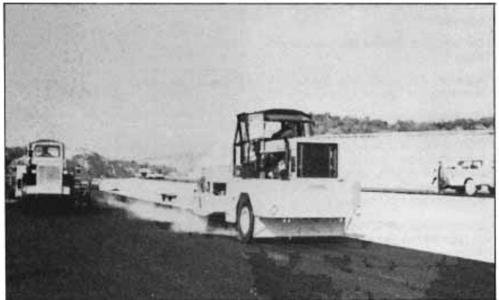
Extendido de la capa de rodadura en una autopista mediante dos equipos en paralelo. Compactación por rodillo mixto de neumático y cilindro vibratorio.
