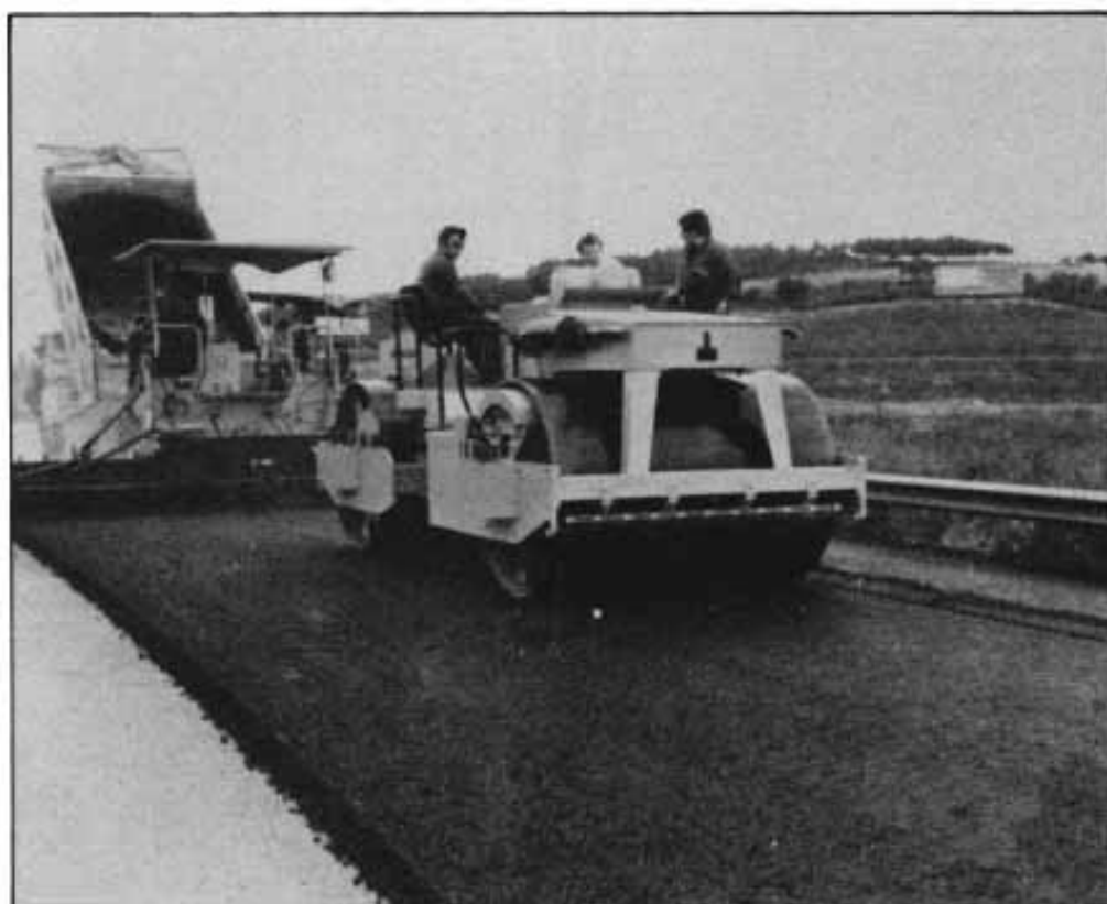
Compactador autopulsado con vibración en ambos rodillos.
