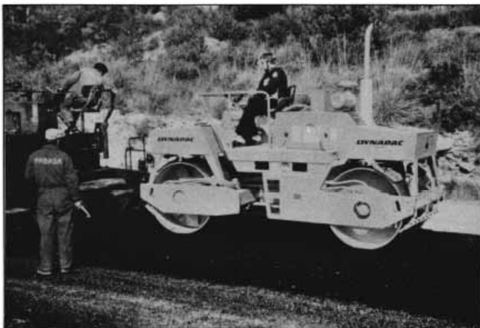
Extendido y compactación de un refuerzo de 12 cm. de espesor mediante vibración.
