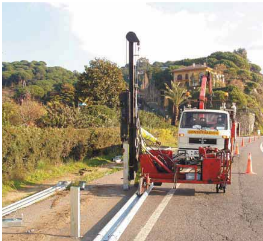
Colocación de barrera metálica.
