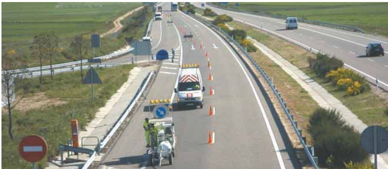
Operaciones de conservación. Señalización horizontal.
