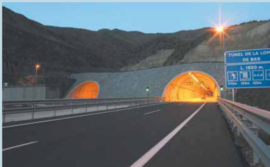
Autopista de peaje AP-7 Cartagena -Vera. Tunel de la Loma de Bas. Fuente: Autopista de la Costa cálida C.E.A.S.A (AUCOSTA).
