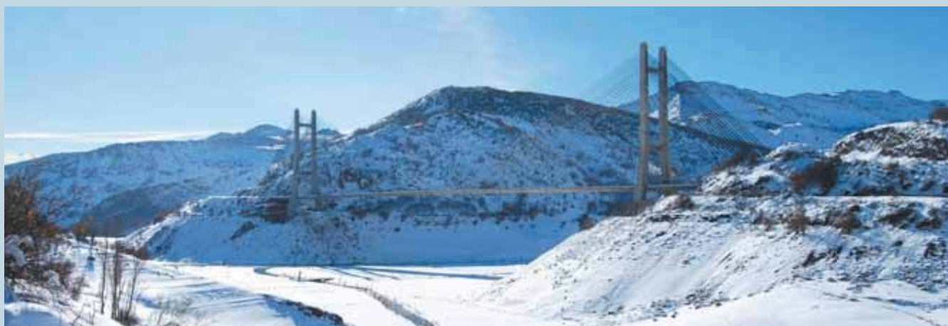
Autopista de Peaje AP-66, Puente Fernández Casado. Fuente: Autopista Concesionaria Astur-Leonesa, S.A. (AUCALSA).
