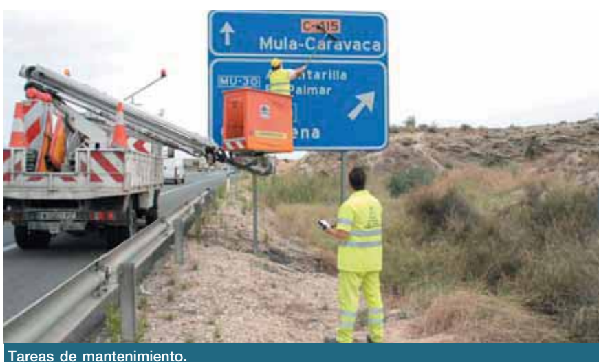
Tareas de mantenimiento.
