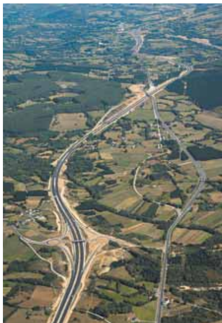
La vista comprende todo el tramo, que discurre en paralelo a la N-634. Se observan las reposiciones de la red de caminos realizada mediante pasos superiores e inferiores.
