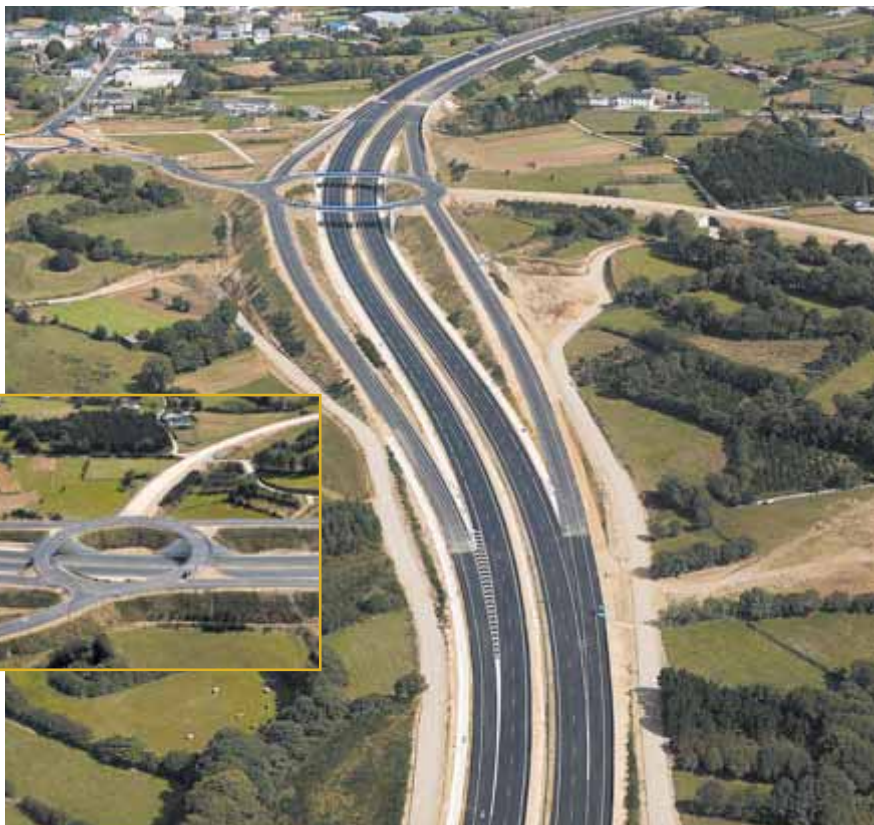
Zona final de la obra, donde se sitúa el enlace de Abadín que conecta con esta localidad a través de una nueva glorieta realizada en la N-634 (a la izquierda de la imagen), y con la carretera autonómica LU-113 Rozas-Abadín todavía en construcción (a la derecha de la imagen).
