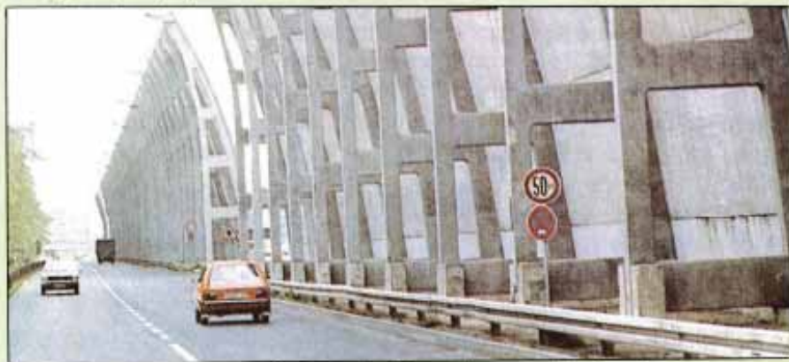
Muro de protección contra el ruido en el Aeropuerto de Frankfurt
