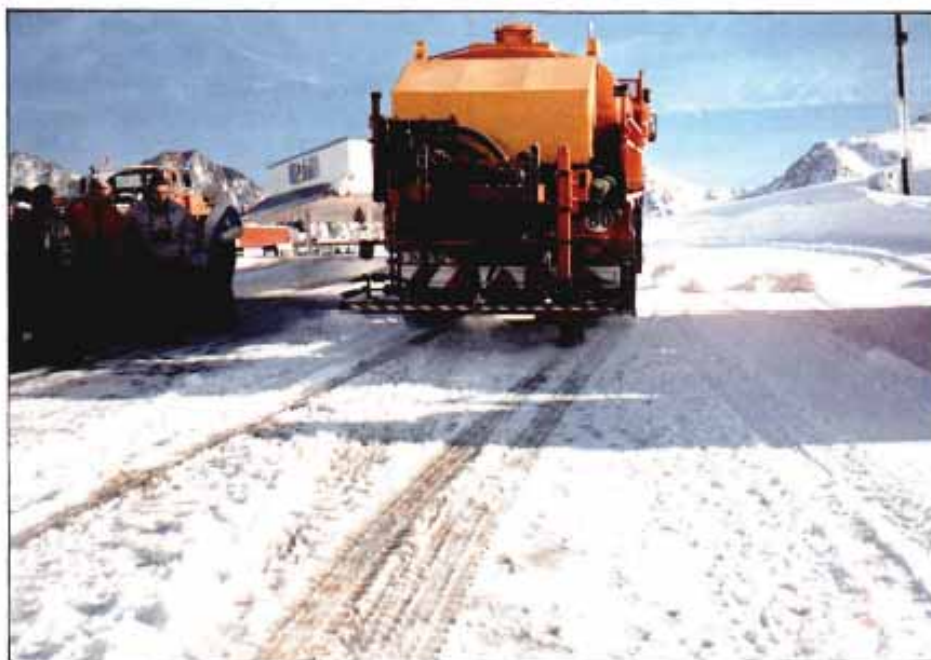
Demostración de maquinaria en el Puerto de Envalira. "Extendidora de qundentes en solución líquida"
