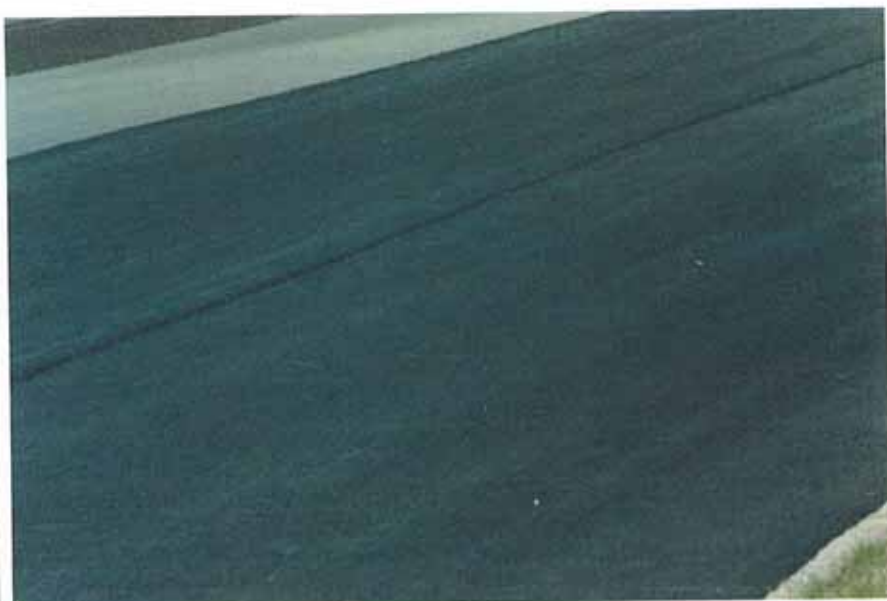
La extensión de una capa de rodadura casi culmina la obra de carretera.
