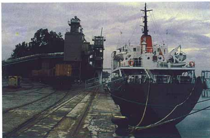
Puerto de Sevilla. Acceso ferroviario.
