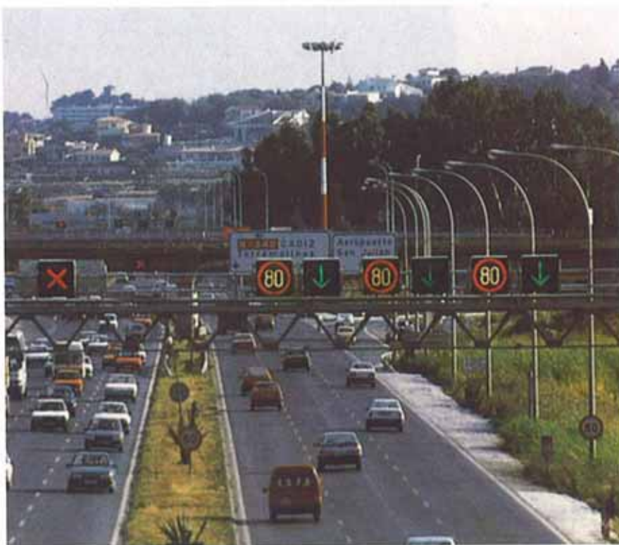
Es deseable que los proyectos de carreteras incluyan un anejo dedicado a Seguridad Vial, que incluya en el detalle requerido, todo lo referente a señalización horizontal y vertical, fija y variable y sistemas de contención de vehículos.
