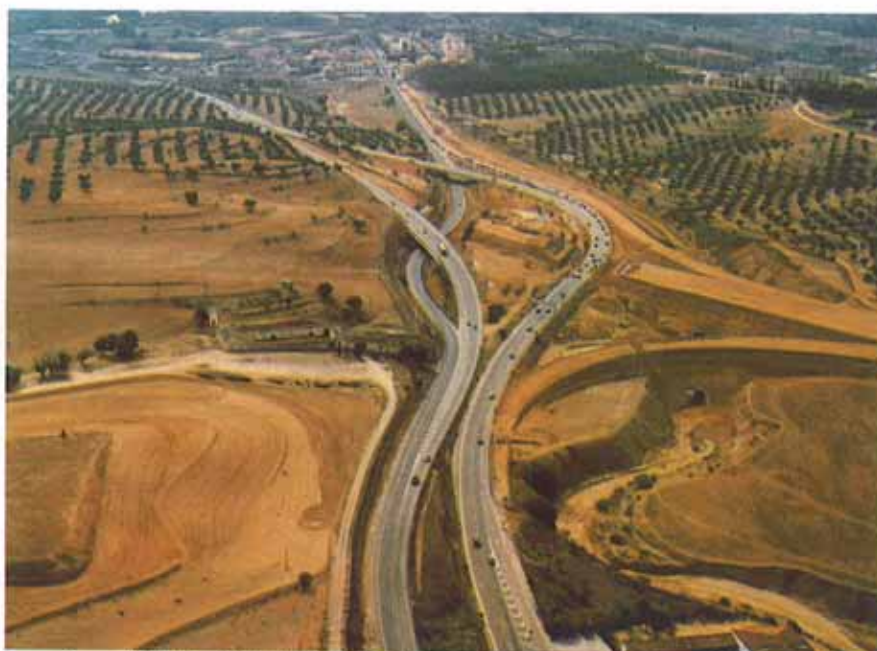
Conexión de la CN-401 y CN-403, Variante de Toledo. Es un tramo parcial de la Red Arterial de Toledo que enlazará las anteriormente citadas y la CN-400. Su plazo de ejecución finaliza en mayo del 93.
