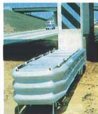
Sólo se podría instalar un sistema de contención de vehículos después de valorar los riesgos potenciales y de destacar soluciones alternativas.
