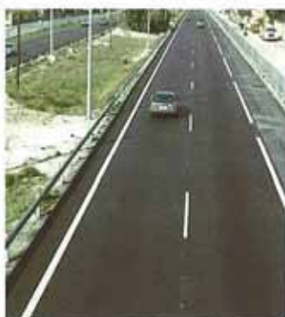
CN-Las Rozas-Villalba, tramo en el que a un betún de destilación directa se le añadió polímeros termoplásticos seleccionados que modificaron la reología del ligante base.
