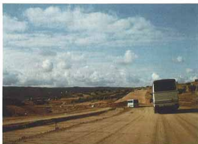
El miércoles, entre otras actividades, se realizó una visita técnica a las obras en ejecución en las carreteras 400 y 401.
