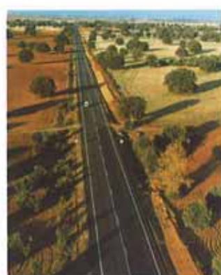
En la foto se aprecia el refuerzo y ensanche realizado en la carretera de La Solana a Tomelloso. Castilla-La Mancha.
