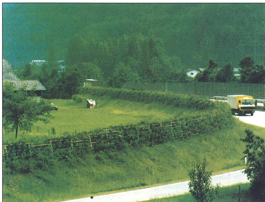
Las pantallas antirruído también pueden tomar la apariencia de "muros vegetales", con una cuidada estructura de hormigón preparada para recibir plantaciones.
