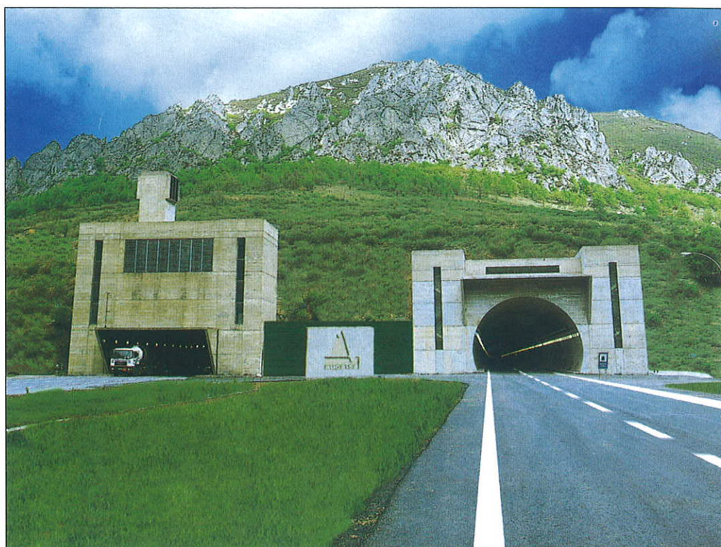
El total de túneles carreteros en nuestro país ronda los 500, con una longitud total de 193 km.
