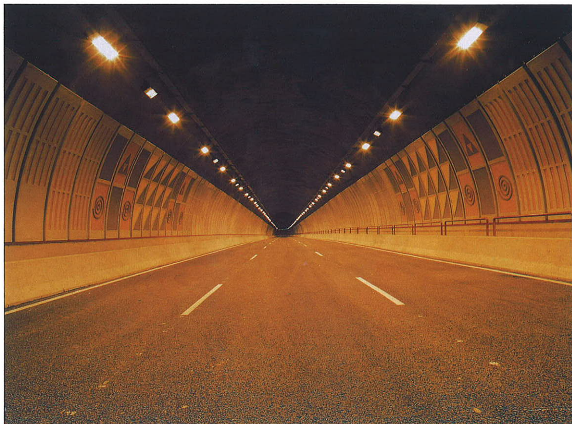
Una buena iluminación, además de dar seguridad, facilita la apreciación de la decoración, lo que, sin duda, reducirá el efecto claustrofóbico del túnel.
