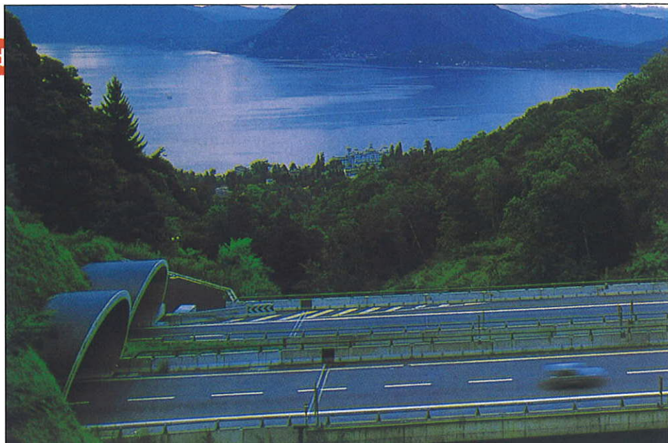
El Informe Nacional de Italia explica cómo la amplitud de los estudios previos con ayuda de perforadoras horizontales en un conocimiento real de los terrenos a la hora de construir túneles.
