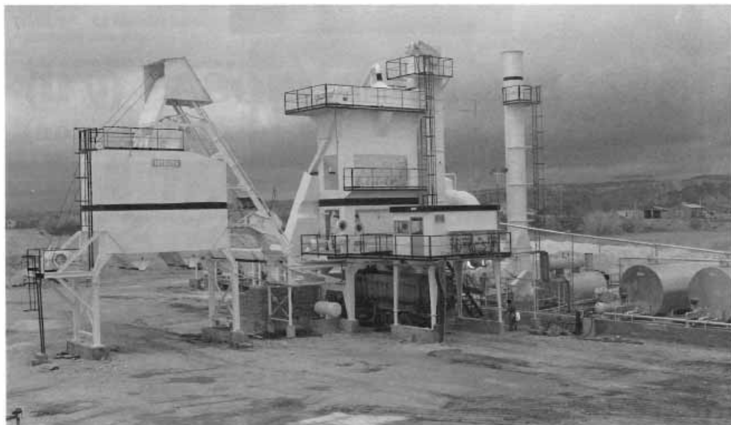
Planta asfáltica equipada con filtros de mangas. Nótese la ausencia absoluta de humo en la chimenea.
