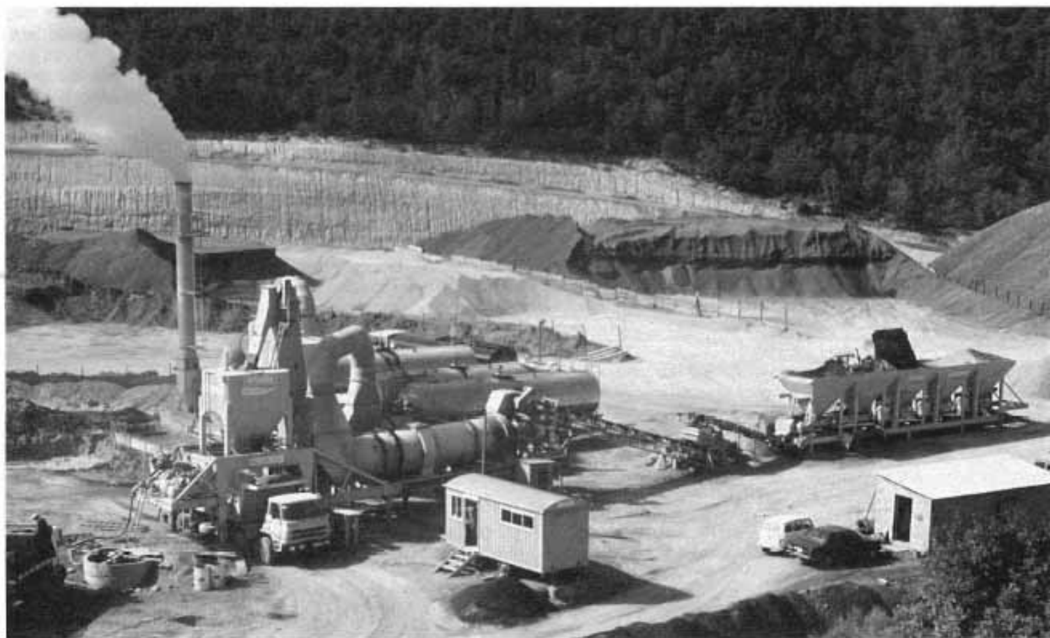
Planta asfáltica equipada con un «Scrubber» como colector de polvo. Nótese el penacho de vapor de agua.
