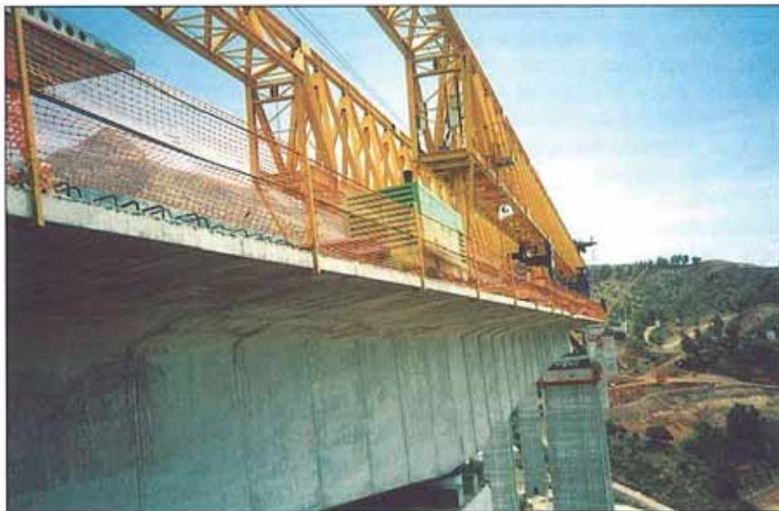
La visita técnica del congreso se realizó a las obras que se están ejecutando en la autopista de la Costa del Sol.
