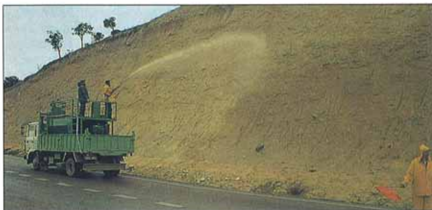
La hidrosiembra de taludes es una actuación común en las obras de carretera.
