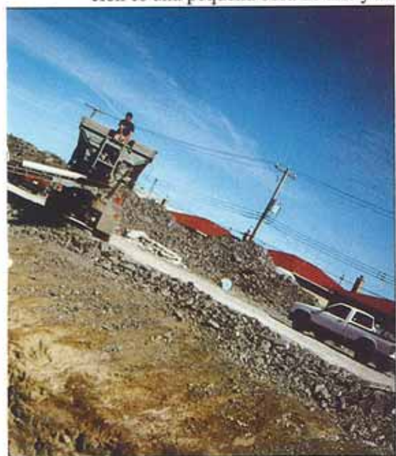
pudieron observar las obras que se realizan en él
