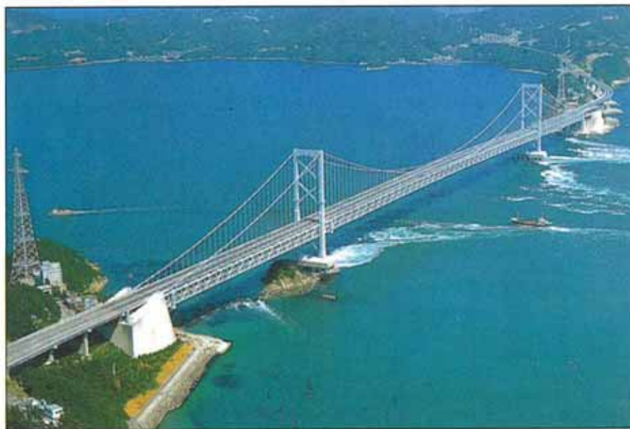
La gestión de los puentes constituye otro elemento estratégico de la gestión de la infraestructuras viales. En la foto, puente de Ohnaruto (Japón)
