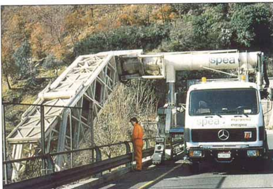
En el caso de los puentes, la principal preocupación parece ser la mejora de las técnicas de diagnóstico y auscultación
