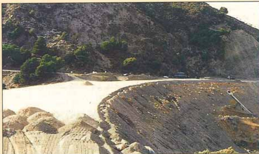
A lo largo de las reuniones, se presentaron diferentes experiencias sobre la utilización de materiales diversos y no siempre, en principio, adecuados para la construcción de terraplenes.
