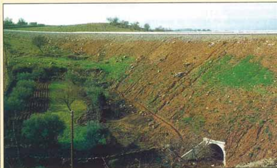
Todas las fases que intervienen en la construcción de un terraplén fueron analizadas y debatidas en este Simposio. En la foto, terraplén Arroyo de las Meriendas (Za-323).
