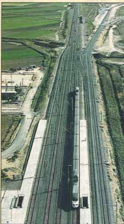
La preocupación por los problemas geotécnicos de los terrenos que atravesaría la línea de alta velocidad Madrid-Zaragoza fue objeto de varias intervenciones. En la foto, la ya existente a su paso por La Sagra (Toledo).
