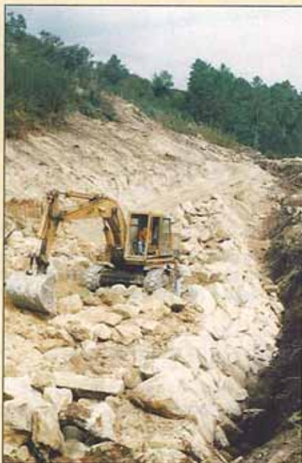
La instantánea recoge la fase de ejecución de un pedraplén en la Autovía Rías Bajas, objeto de la visita técnica.
