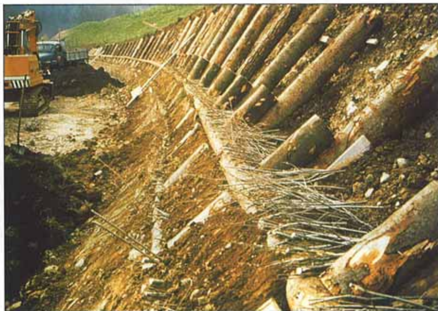
Detalle de proceso técnico. Utilización de material vegetal (troncos y esquejes de arbustos) para estabilizar taludes.
