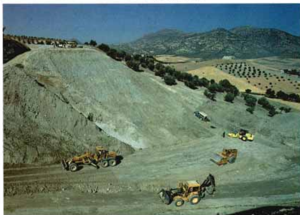
Obra de explanación en la autovía de Aranjuez.
