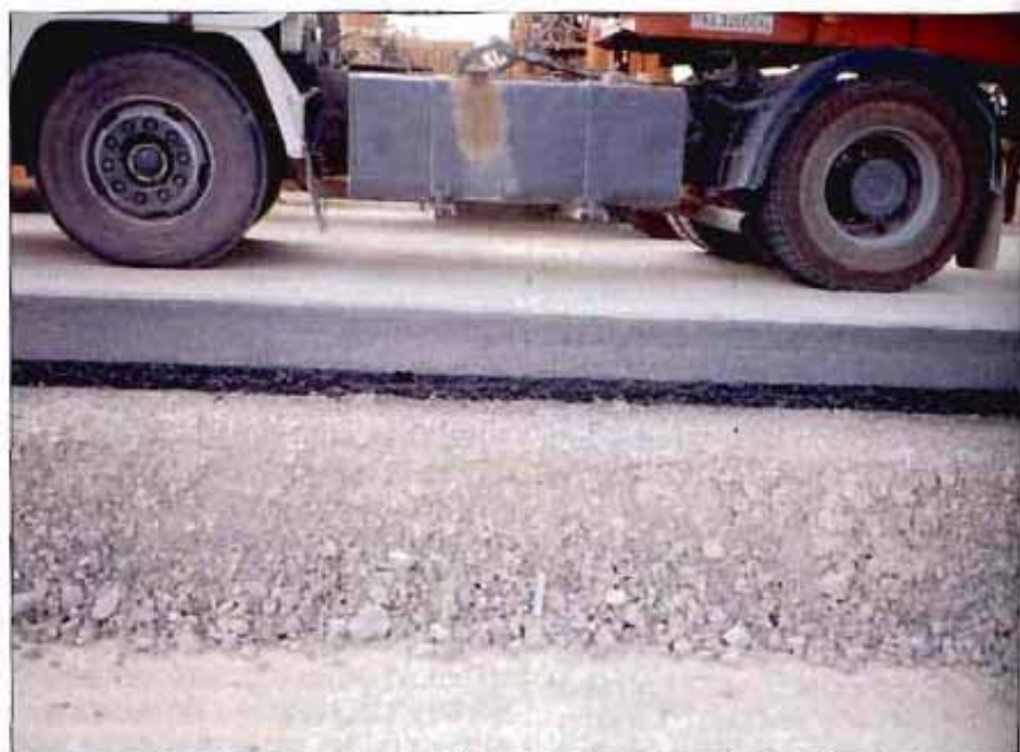
Autovía Zaragoza-Villanueva. Pavimento de hormigón sobre base bituminosa porosa.
