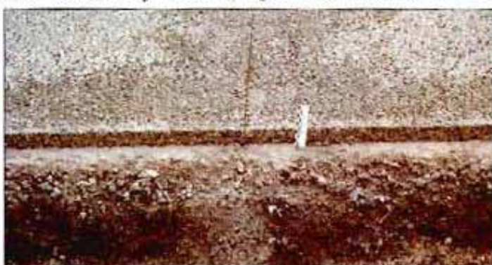
Capa de rodadura de hormigón poroso. Eje del Culebro. Madrid.
