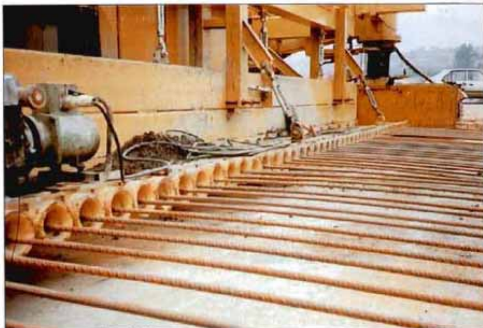
Autovía Oviedo-Pola de Siero. Colocación de armaduras con trompetas en pavimento continuo de hormigón armado.
