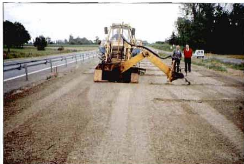
Máquina CRAFT para la formación de juntas en fresco para hormigón compactado.
