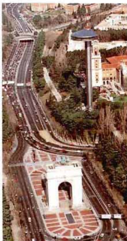
Visita técnica nº 2. Obra en la N-VI. Tramo Moncloa-Villalba. Subtramo Moncloa-Puerta de Hierro.
