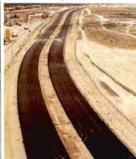
Visita técnica nº 1. Obras del Distribuidor Deste, enlace de la A-5 con la A-6. M-40. Vista aérea desde el p.k. 4+200.
