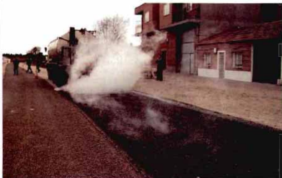
En la foto, vemos cómo el camión cisterna "rieha", en uno de los tramos objeto de demostración en la visita técnica.
