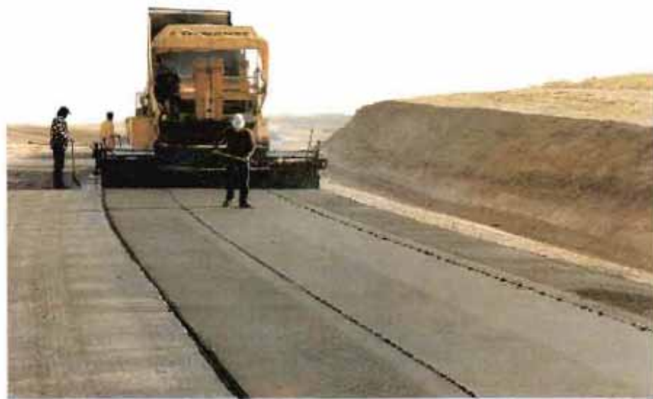
Extensión de una capa fina, antifisurable, para evitar la reflexión de grietas de la grava-cemento subyacente.
