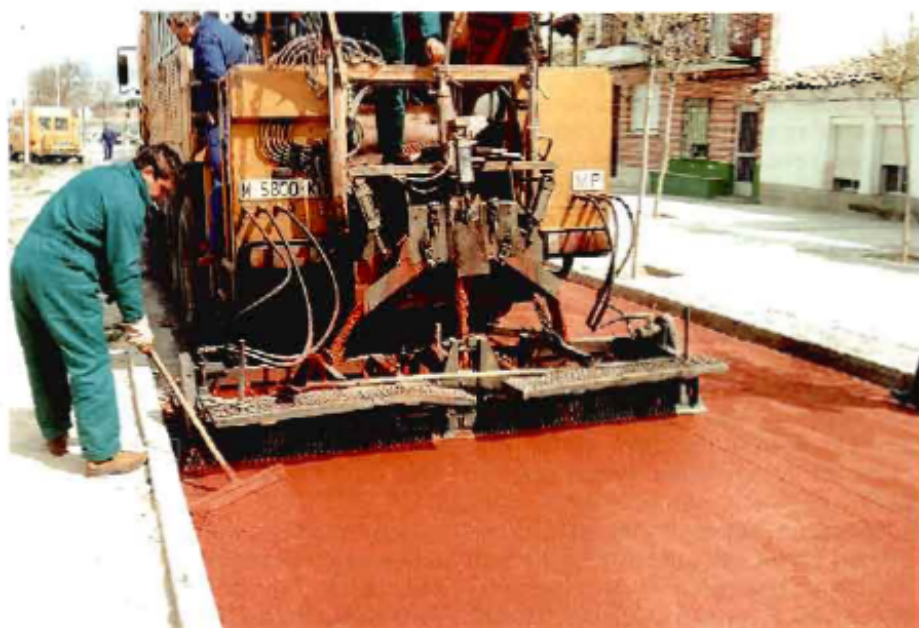
Trabajos de extendido durante la visita técnica.
