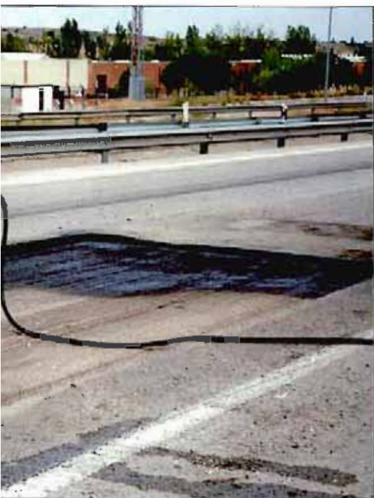
Riego anterior al extendido de la capa de rodadura.
