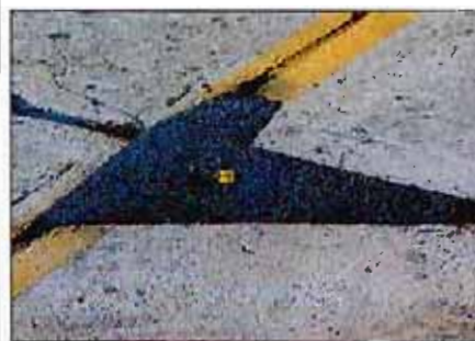
Reparación con material bituminoso y eliminación de la junta.
