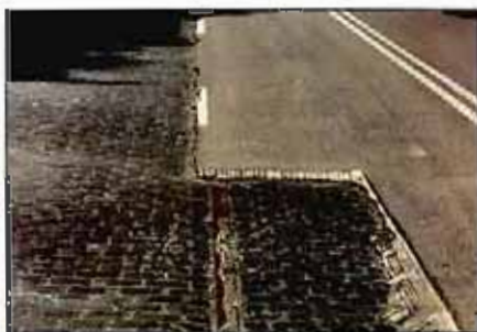
En la foto se aprecia el buen estado del adoquinado primitivo, tras retirar el pavimento existente.
