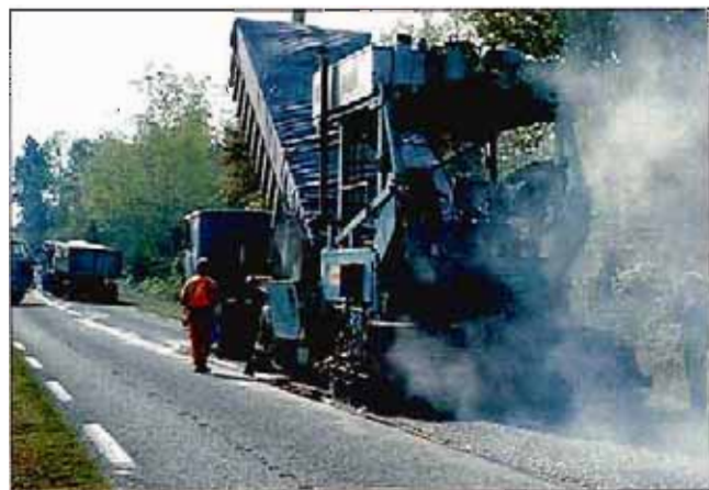
Reposición de firme en carretera convencional.
