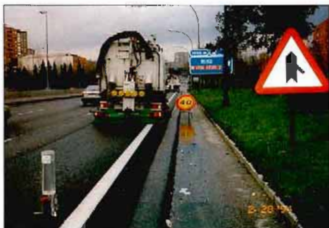
Ensayo de limpieza de superficie de mezclas drenantes, realizado en una autovía de acceso a Madrid.
