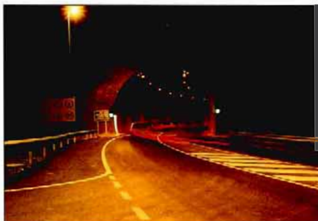
Casi el 50% de los vehículos circulan a velocidad antirreglamentariamente en el interior de los túneles.
