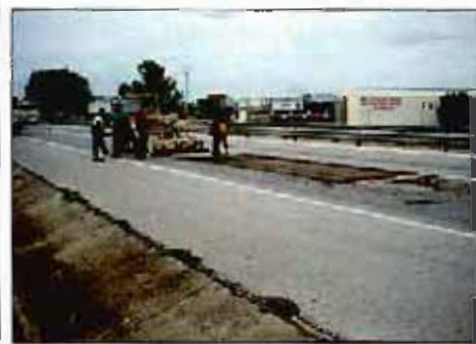
Operación de saneamiento de un firme de autovía.
