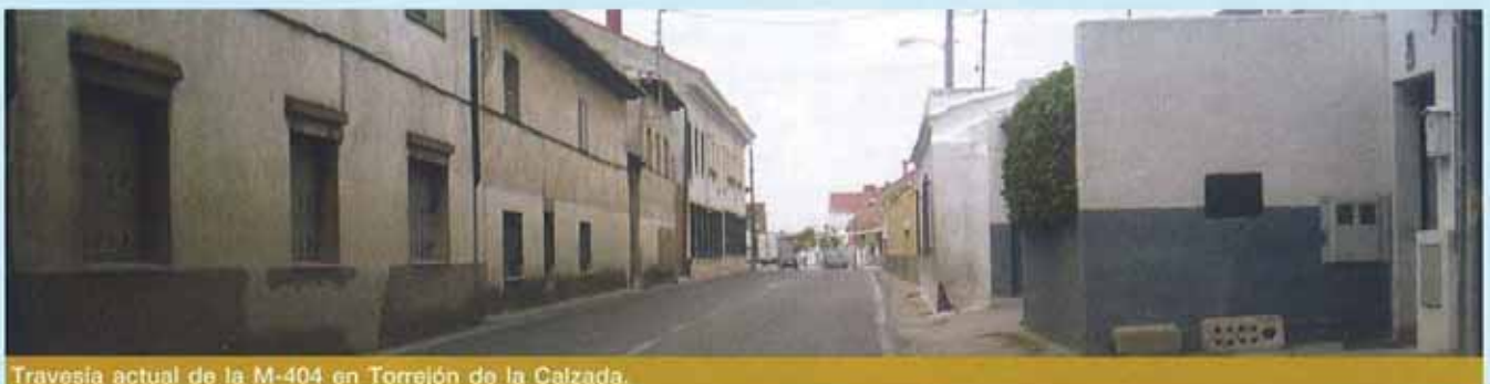
Travesía actual de la M-404 en Torrejón de la Calzada.
