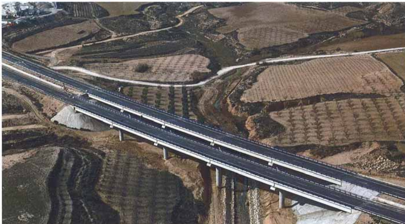
Viaducto sobre el Barranco Salado, de 187 m de longitud, compuesto por dos estructuras de cinco vanos.
